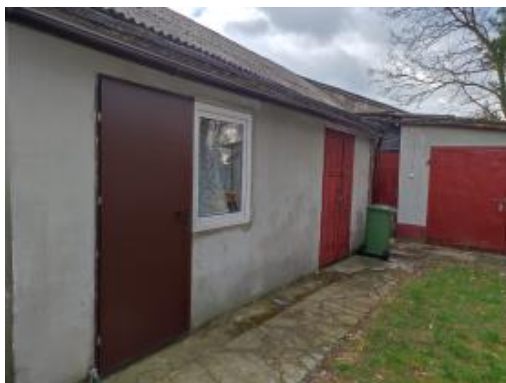
Fot. 9 Widok z zewnątrz budynku
