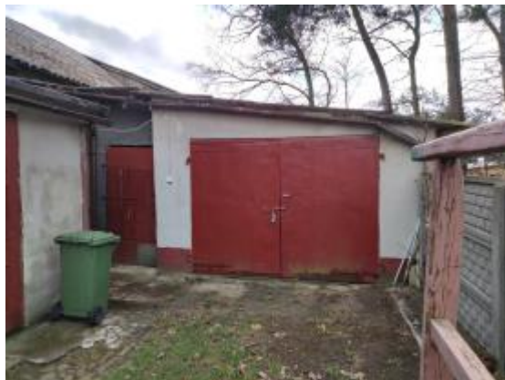
Fot. 13 Ściana frontowa garażu
